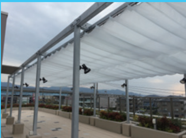
●共用部通路の雨除け
