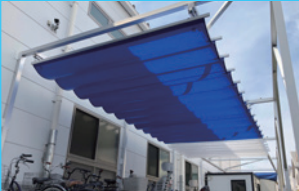
●駐輪場の雨除け
