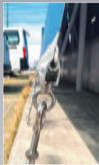
アイボルトも取り付け可能で、ターンバックルでの張り上げも可能。
