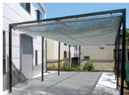
●工場休憩場の日除け
