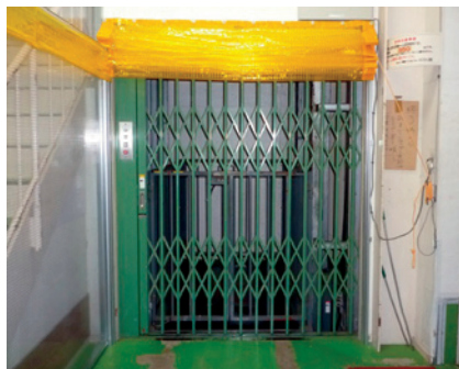
●開口部にビニールシャッター
