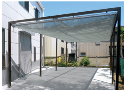
●工場休憩場の日除け
