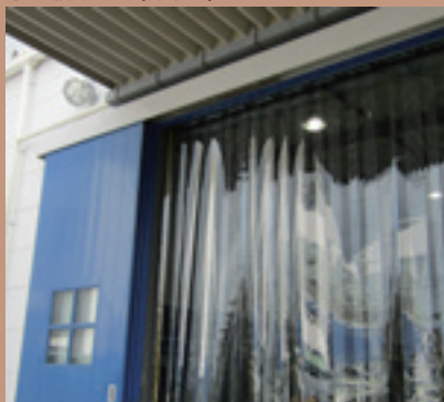
●工場出入口（可動式）
