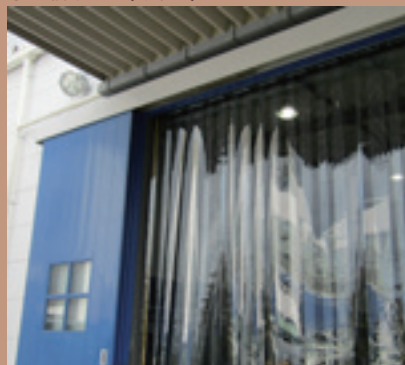
●工場出入口（可動式）
