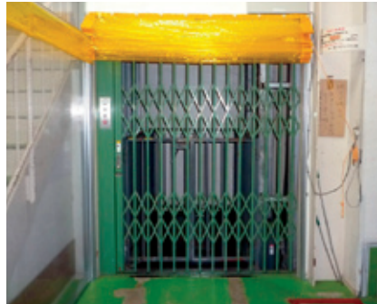
●開口部にビニールシャッター
