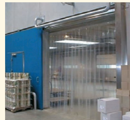
■倉庫内の間仕切（冷蔵）
