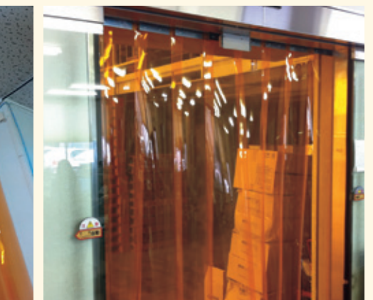
■事務所出入口
