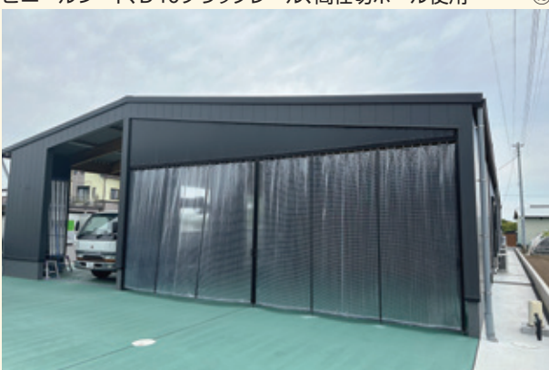
雨・風除け 防塵 ビニールシート、D40ブラックレール、間仕切ポール使用
