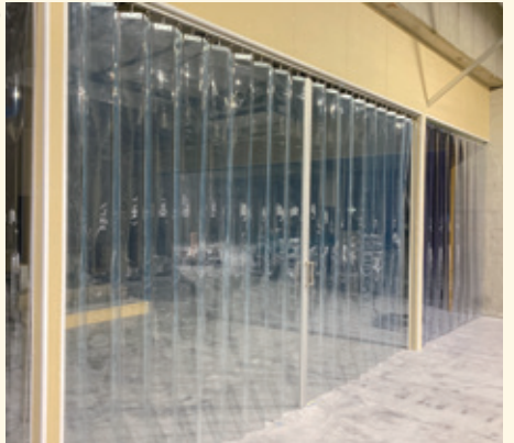
保温・保冷 防塵 アコーディオンシート、D40レール、間仕切ポール使用 ④
