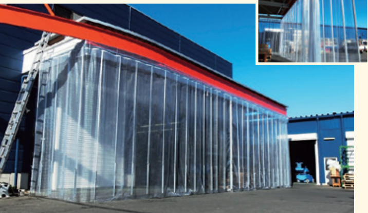
雨・風除け 防塵 ビニールシート、SGレール、間仕切ポール使用
