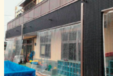
防塵 雨・風除け ビニールシート、D30レール使用 ⑮
