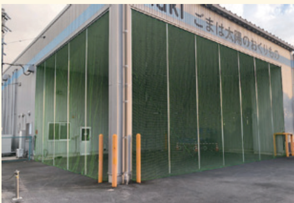
ネット ネット、XGレール、ネットBOXバー使用
