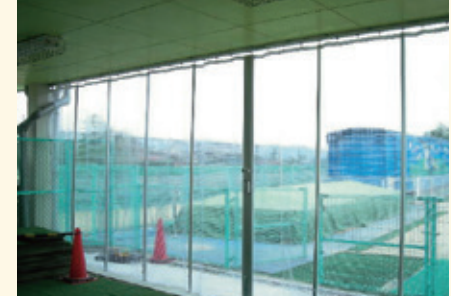
雨・風除け 防雪 ビニールシート、D30レール、間仕切ポール使用 ⑮
