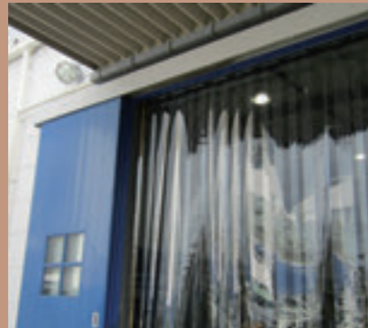
●工場出入口（可動式）
