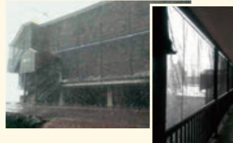
マンションベランダ 防鳥 防鳥ネット、D30レール、間仕切ポール使用
