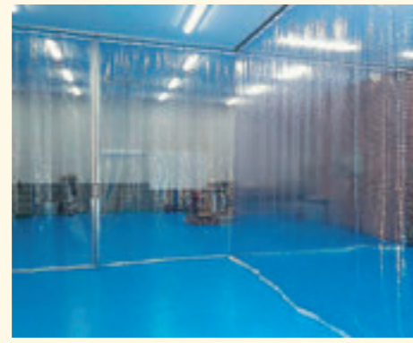
保温・保冷 飛散防止 防塵 ビニールシート、D40レール、間仕切ポール使用
