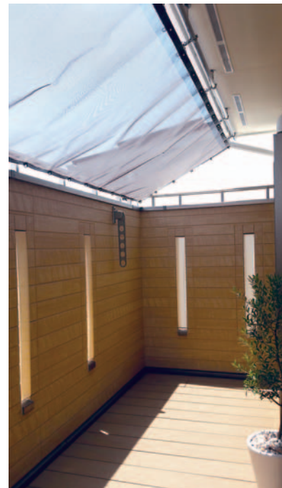
●住宅バルコニーの日除け
