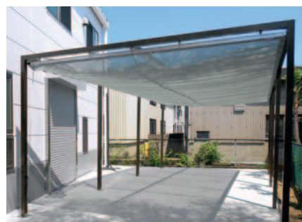
●工場休憩場の日除け
