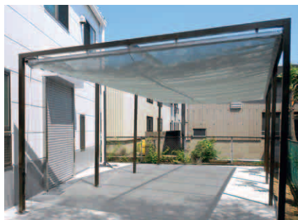
●工場休憩場の日除け
