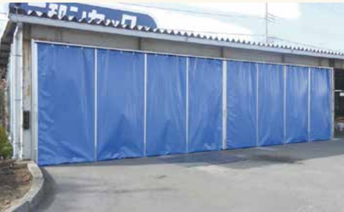
防鳥 テントシート、XGレール、間仕切ポール使用
