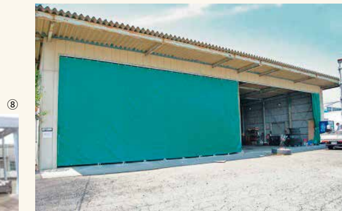
倉庫開口部 雨・風除け 防塵 テントシート、XGレール、間仕切ポール使用
