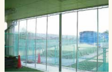
雨・風除け 防雪 ビニールシート、D30レール、間仕切ポール使用 ⑱
