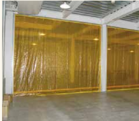
断熱 断熱シート、D40レール、間仕切ポール使用 ⑧
