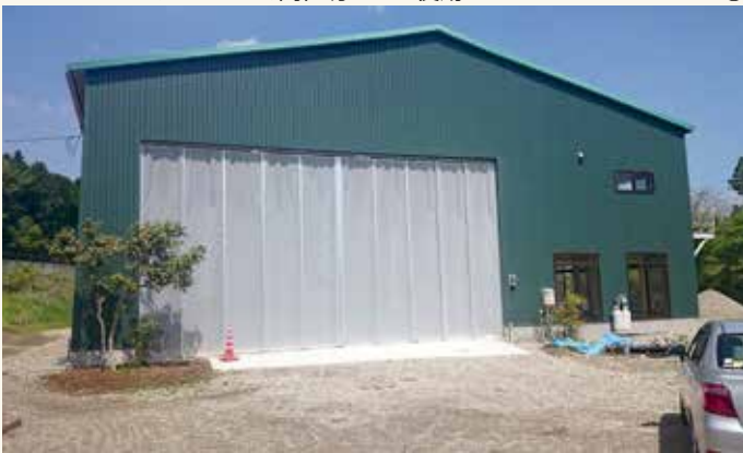
雨・風除け 防塵 ビニールシート、SGレール、間仕切ポール使用
