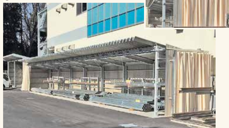
レールを90°曲加工、 シート開放時に倉庫左右の側面に収納
